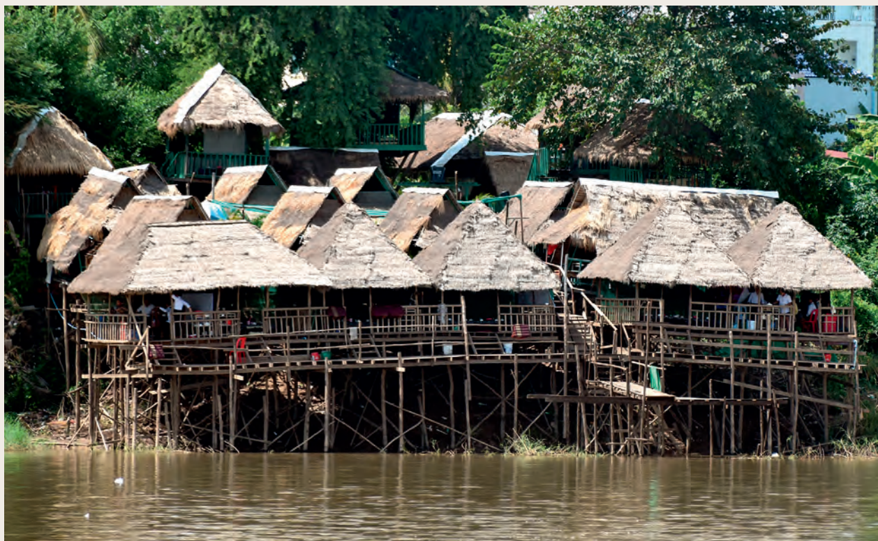
Langs Mekongfloden i Cambodia bygger man huse på pæle
